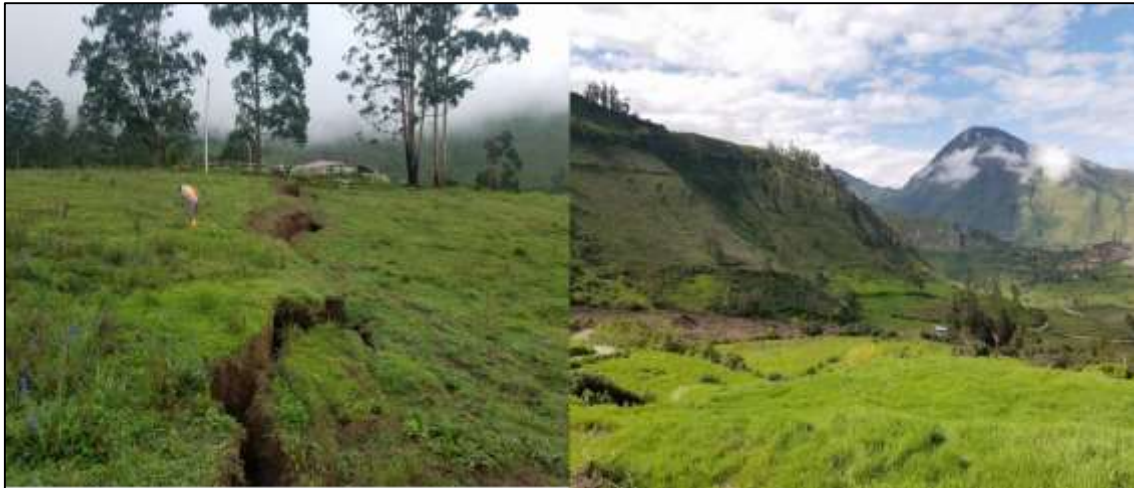
Figura 6 Grietas de tracción y escarpes erosivos previo al deslizamiento Fuente: SNGRE, 2021.
