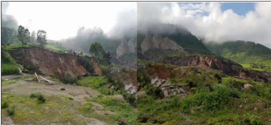
Figura 7 Zonas de Grietas de tracción y escarpes erosivos posterior al deslizamiento Fuente: SNGRE, 2021.
