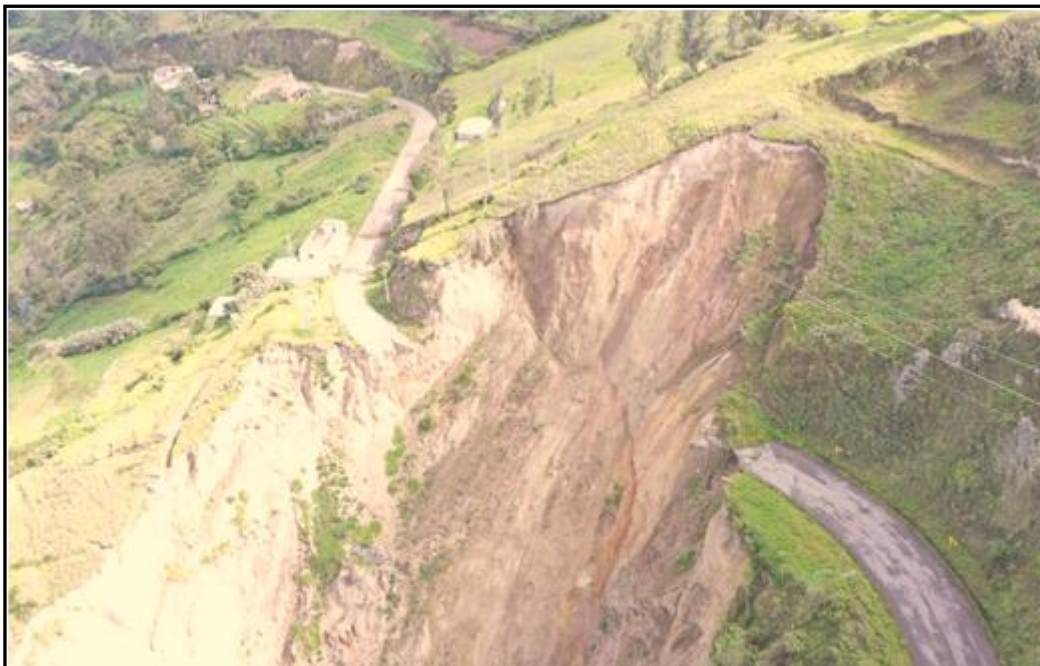
Imagen 7: Imágenes en la parte alta del escarpe principal, sobre la vía.
