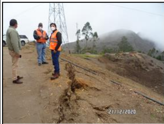
Imágenes 1 y 2: Afectaciones a la vía de tercer orden en la parte alta del deslizamiento.
