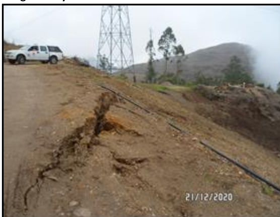
Imágenes 3 y 4: Afectaciones a la vía de tercer orden en la parte alta del deslizamiento.
