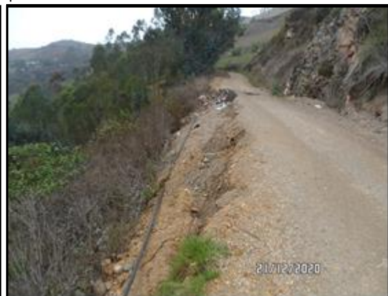
Imágenes 3 y 4: Afectaciones a la vía de tercer orden en la parte alta del deslizamiento.
