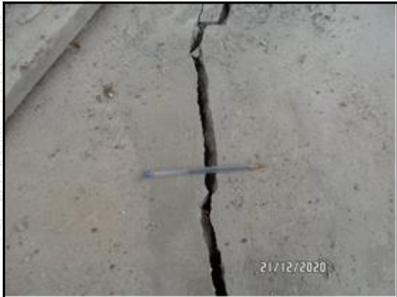
Imágenes 3 y 4: Afectaciones sobre una vivienda en la parte alta del deslizamiento.
