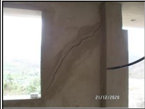
Imágenes 1 y 2: Afectaciones sobre una vivienda en la parte alta del deslizamiento.
