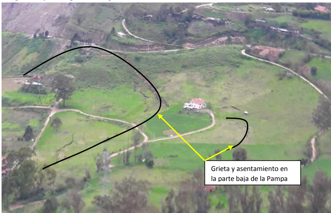
Imagen 10: panorámica de las grietas en dirección oeste de La Pampa.01/04/2022
