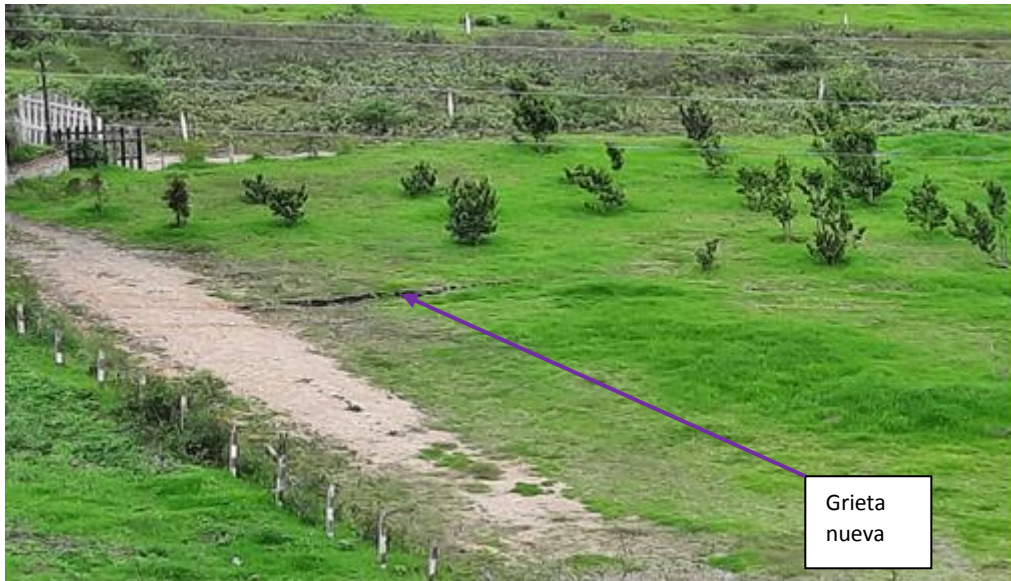
Imagen 11: panorámica de las grietas en dirección oeste de La Pampa.01/04/2022
