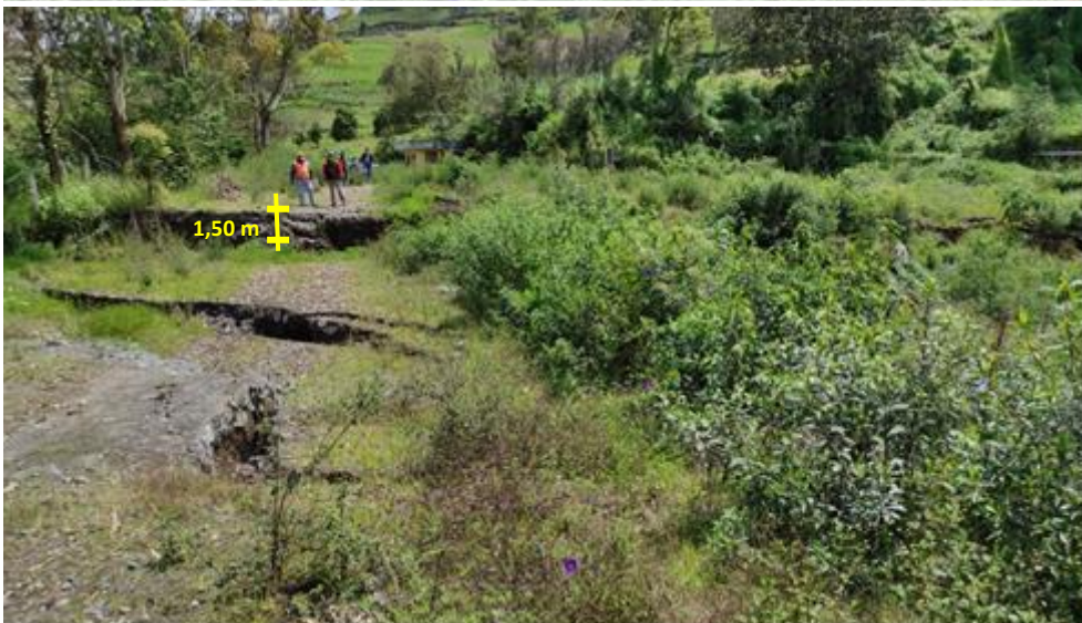
Imagen 5, 6 y 7: Imagen de las grietas en el sector Piscinas de oxidación.01/04/2022
