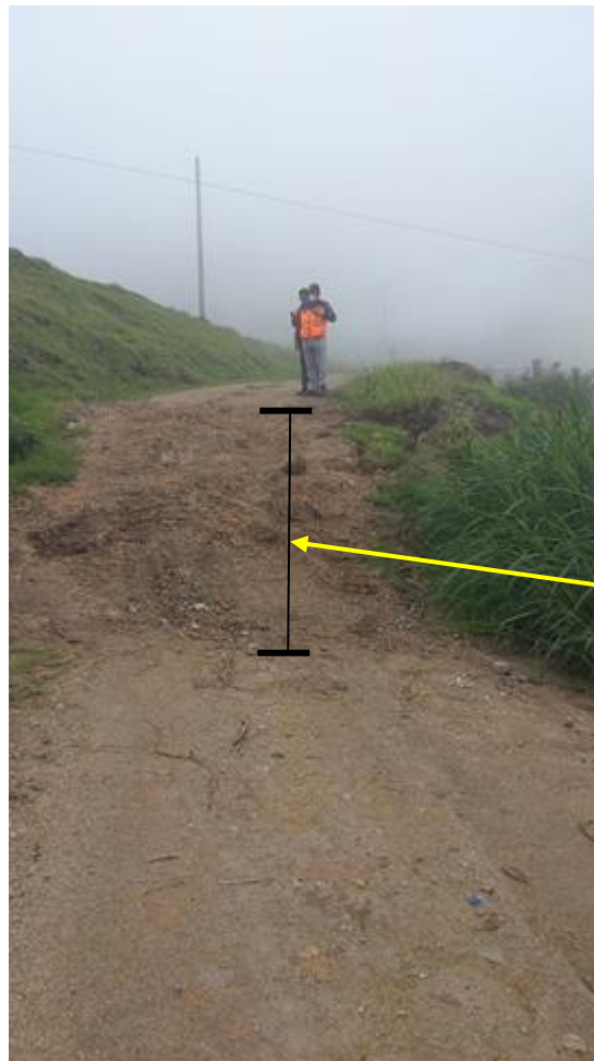
Imagen 6: Imagen del asentamiento de la vía de ingreso a la galería.15/02/2022
