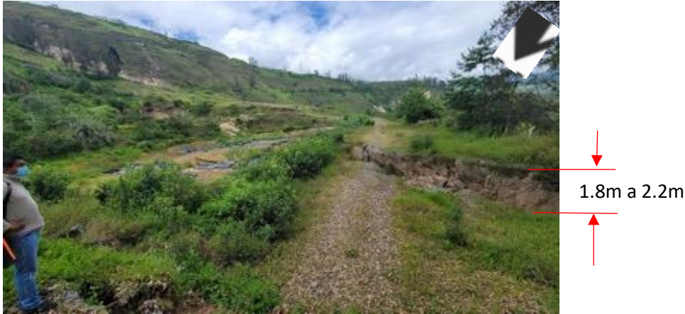
Imágenes 6, 7, 8 y 9: Grietas expuestas en la Piscina de oxidación
