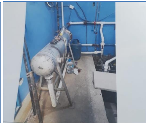
Repotenciación del caldero
