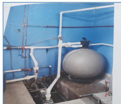
Instalación y reemplazo de tubería
