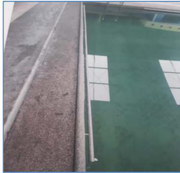
Instalación de tubo perimetral
