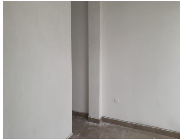
Mampostería interna enlucida y estucada
