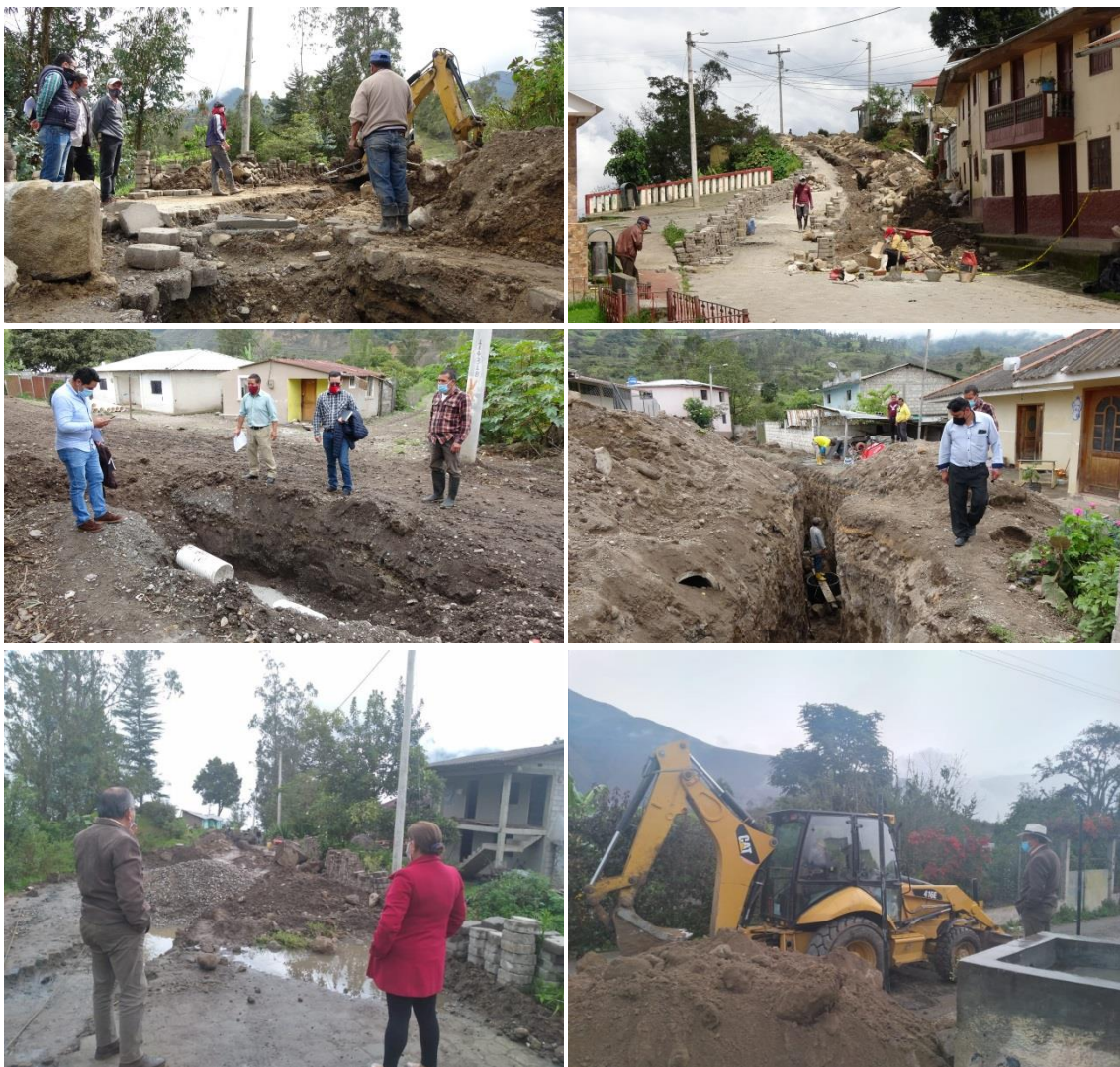
Fotografía 14 Labores de alcantarillado en Piñancay y Compud
