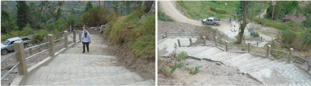
Fotografía 67 Reconstrucción del Graderío Gruta de Agua Santa - Picay
