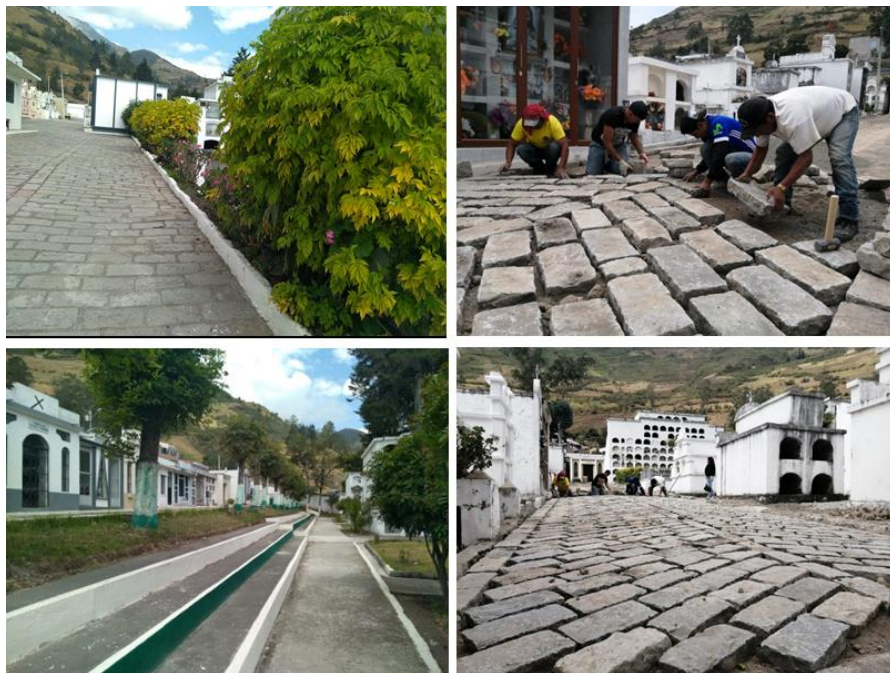
Fotografía 68 Labores de mejoramiento en el Cementerio General de Chunchi
