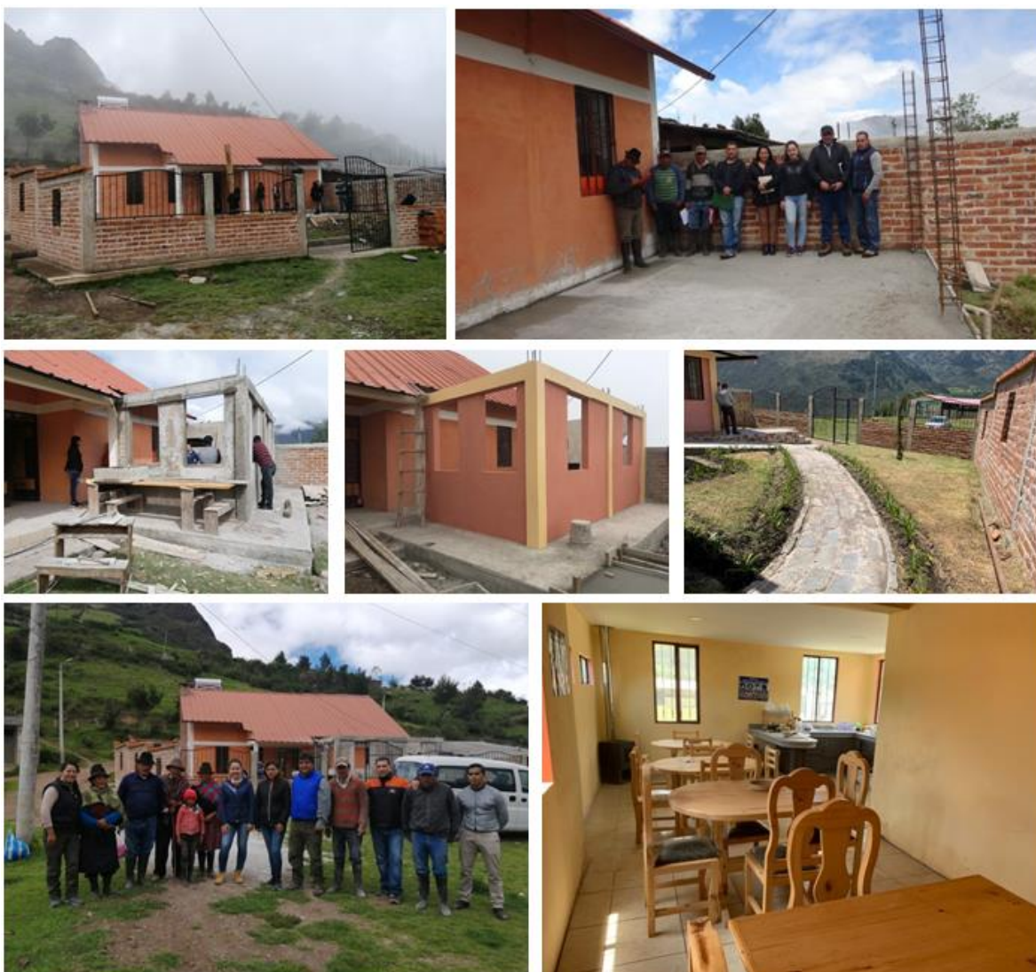
Fotografía 61 Intervención en el refugio turístico “La Parada del Inca” - Launag Grande
