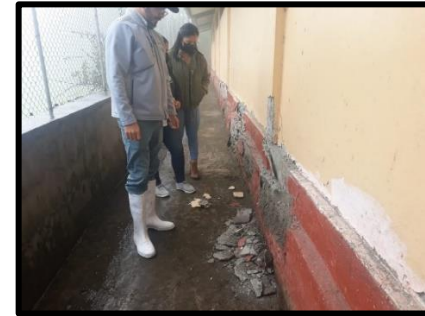
Inspección CDI Llagos
