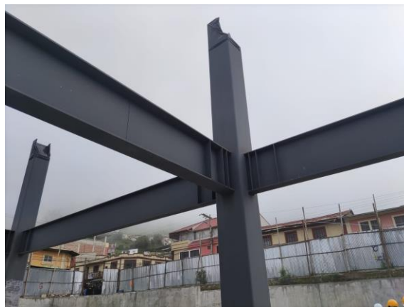
Figura 4: Columnas de acero
