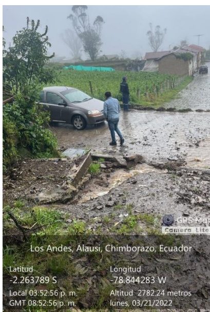
Ilustración 13 Imagen de zona afectada en Gonzol.
